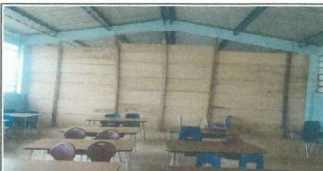
Foto 5: Se observa que la división entre salones en el edificio No. 1, específicamente en el salón de primero primaria, ha sido construida de manera improvisada con madera. Esta estructura presenta deficiencias en estabilidad y aislamiento.
