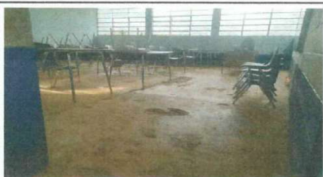
Foto 3: Se observa el deterioro de la torta de concreto en el salón de primero primaria, presentando grietas y desgaste en su estructura.
