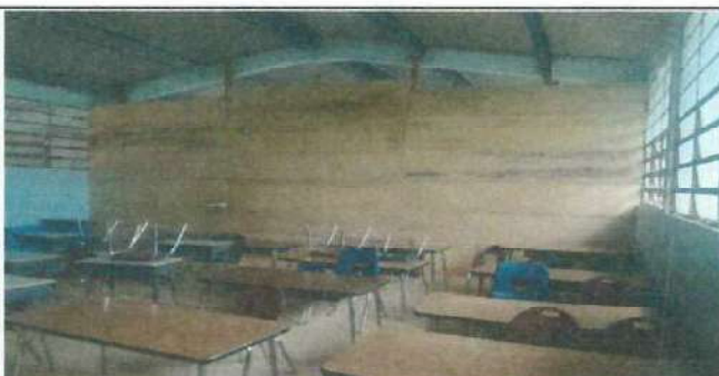
Foto 5: Se observa que la división entre salones en el edificio No. 1, específicamente en el salón de segundo primaria, ha sido construida de manera improvisada con madera. Esta estructura presenta deficiencias en estabilidad y aislamiento.
